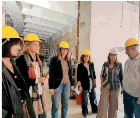
Teatro Bucci. Visita del sindaco Vadi per l'avanzamento dei lavori
